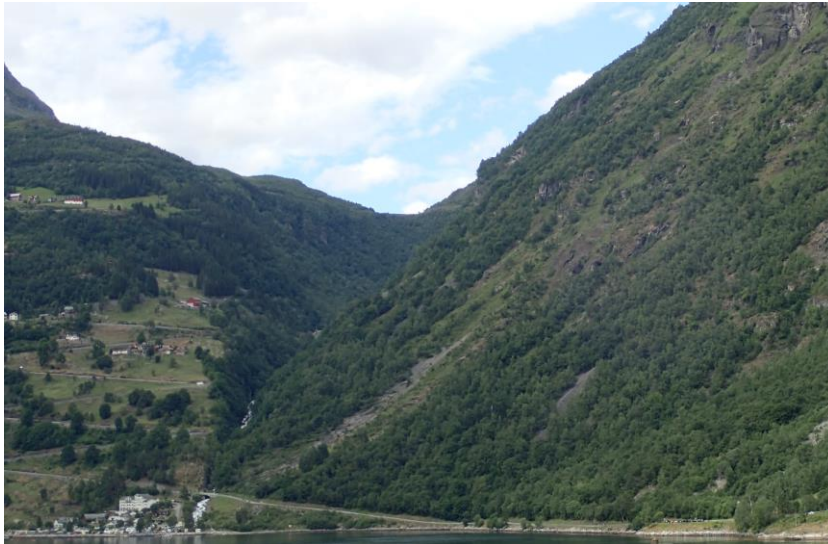
Stranda kommune: Grandefonna i Geiranger. Bildet viser ganske store rasmarksenger på østsida av Grandeelva. Det rasløpet som kommer ned omtrent ved utløpet av Grandeelva kalles Grandefonna.
