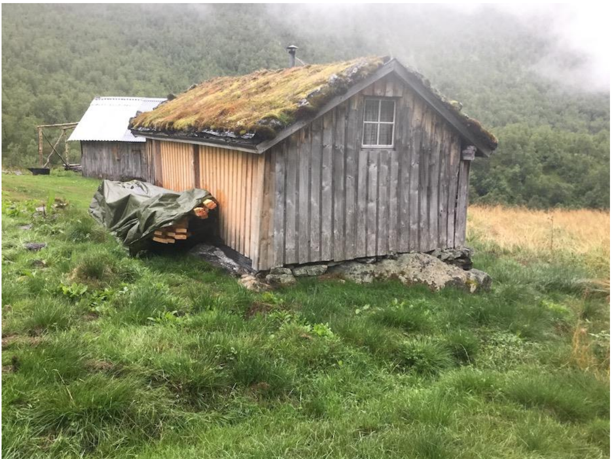
Figur 1 Eit av stølshusa på Tafjordsætra, med torv på taket og umåla vegger. Foto: Geir Gaarder
