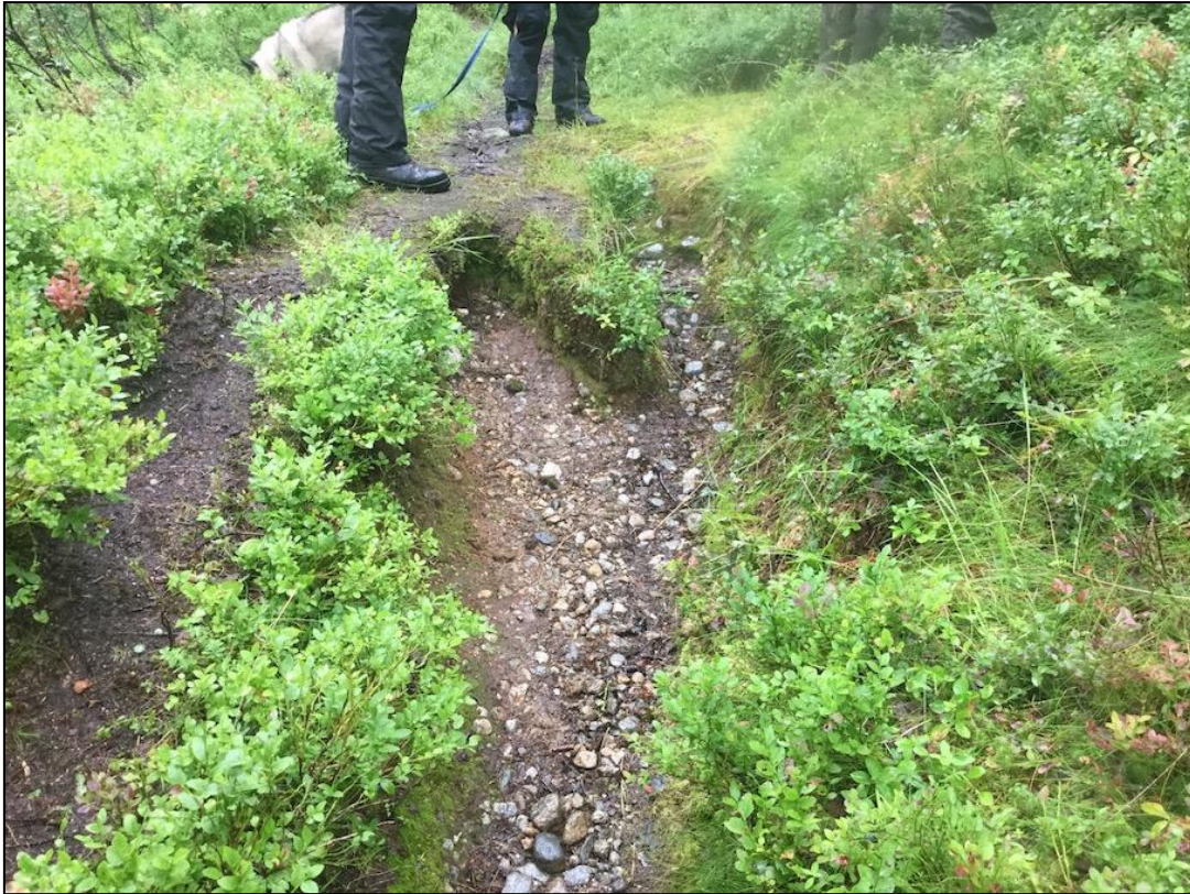
Figur 6 Parti av stien inn til Muldal- og Tafjordsætra der vatnet har fått tak og grove seg ned i lausmassane. Ikkje minst kan det vere trong for å leie vatnet vekk frå stien slik at det ikkje grev enno meir. Truleg er det vanskeleg å gjere noko meir med den delen som alt har vorte skada, utan å frakte hit massar og fylle att. Foto: Geir Gaarder
