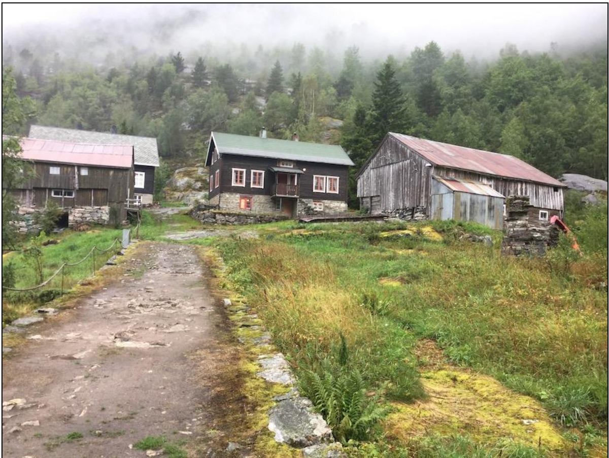
Figur 16 Muldal sett frå vegen som går opp til gardsbruket. Det er litt skiftande kor godt vedlikehaldne husa har vore dei seinare åra, men alle ser ut til å ha gode tak og nokre av dei er velstelte. Foto: Geir Gaarder
