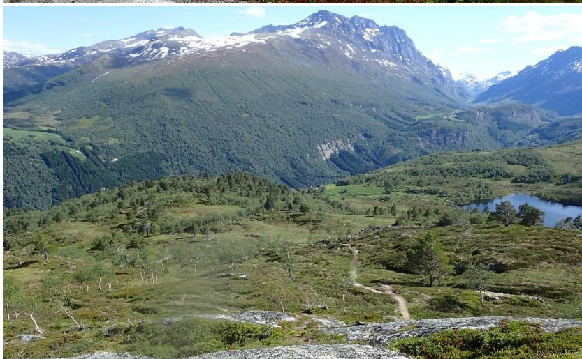
Utsikt fra Blåhornet mot Kilstivatnet og Kilsti, strekning 60-64 er mest synlig.
