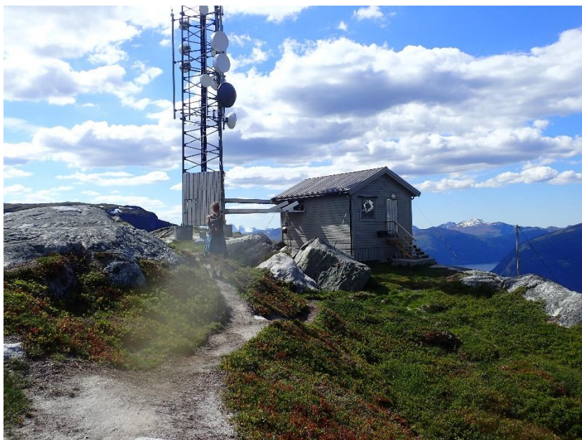
Blåhornet, strekning 58-59. Stien går i fjellhei, og er noen steder er det erodert i et par meters bredde.
